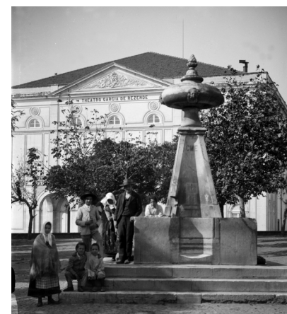
Fig.18- Fonte na Praça Joaquim António de Aguiar Fonte: Arquivo Fotográfico da CME- GPE0314
