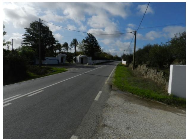
Fig. 10 EN18 no troço periurbano, com largura cerca de 7m nas faixas de rodagem e bermas
