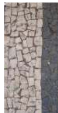
Gráfico 32- Estado de conservação do pavimento (Pass. 05) em calçada tradicional portuguesa de vidro e basalto
