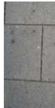
Gráfico 19- Estado de conservação do pavimento (Pass. 07) em lajeado de granito com espessura igual ou sup. a 0,10m
