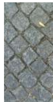
Gráfico 27- Estado de conservação do pavimento (Pass. 14) em calçada de cubos de granito de 11x11 em fiadas regulares oblíquas ao eixo da via
