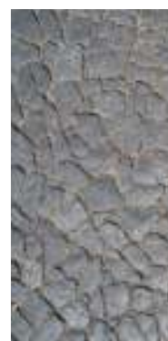
Gráfico 33- Estado de conservação do pavimento (Pass. 10) em calçada tradicional miúda de basalto
