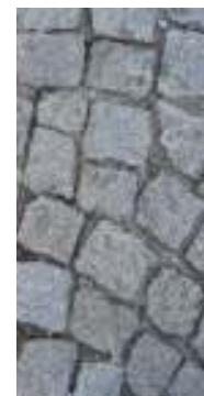
Gráfico 38- Estado de conservação do pavimento (Rod. 04) em calçada de cubos de granito de 11x11 com dimensão e assentamento irregulares
