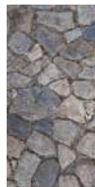
Gráfico 34- Estado de conservação do pavimento (Pass. 11) em calçada tradicional miúda de granito e outros
