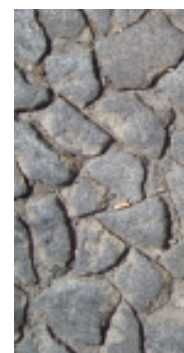
Gráfico 26- Estado de conservação do pavimento (Pass. 02) em calçada tradicional grossa de granito
