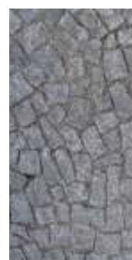
Gráfico 16- Estado de conservação do pavimento (Pass.04) em calçada irregular de granito com face plana
