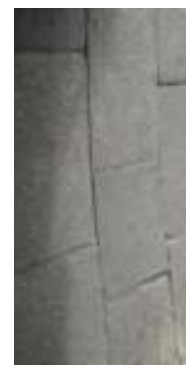
Gráfico 18- Estado de conservação do pavimento (Pass. 06) em lajeado de granito com espessura sup. a 0,15m
