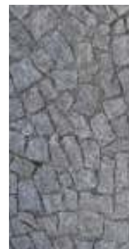
Gráfico 30- Estado de conservação em pavimento (Pass. 04) em calçada irregular de granito com face plana
