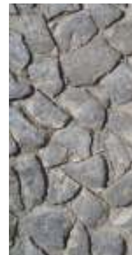
Gráfico 39- Estado de conservação do pavimento (Rod. 05) em calçada tradicional grossa de granito
