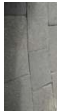
Gráfico 35- Estado de conservação do pavimento (Pass. 06) em lajeado de granito espessura sup. a 0,15m
