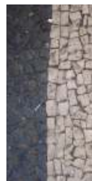
Gráfico 17- Estado de conservação do pavimento (Pass. 05) em calçada tradicional portuguesa de vidro e basalto
