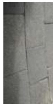
Gráfico 43- Estado de conservação do pavimento (Pass. 06) em lajeado de granito com espessura sup. a 0,15m
