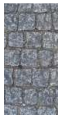
Gráfico 10- Estado de conservação do pavimento (Rod. 03) em calçada de cubos de granito de 11x11 em fiadas regulares paralelas ao eixo da via
