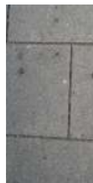
Gráfico 44- Estado de conservação do pavimento (Pass. 07) em lajeado de granito com espessura igual a 0,10m
