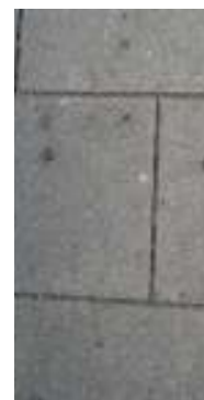
Gráfico 36- Estado de conservação do pavimento (Pass. 07) em lajeado de granito com espessura igual ou superior a 0,10m
