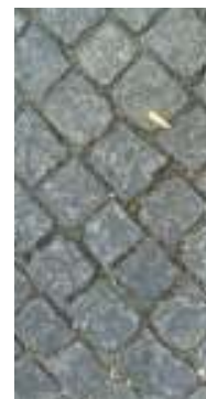
Gráfico 10- Estado de conservação do pavimento (Rod. 03) em calçada de cubos de granito de 11x11 em fiadas regulares paralelas ao eixo da via
