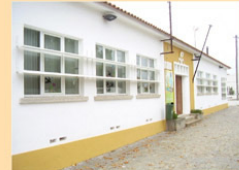
Fachada Nascente com Lâminas de Sombreamento nas Janelas
