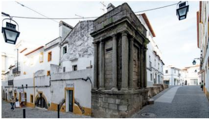
Estructura hidráulica del Acueducto con función de aireamiento, decantación e inspección. Tiene la forma de un pequeño templo clásico, posiblemente asociado simbólicamente al terminal de agua junto a las murallas, en memoria del "Castillo de Agua" romano. La obra data de los años 1536/37 y está atribuida al arquitecto Miguel de Arruda.
