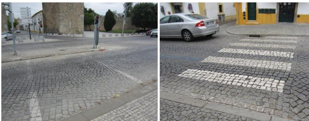
**Figura 70. Inexistência de rebaixamentos de acesso a passadeira, ou a sua incorreta execução**
