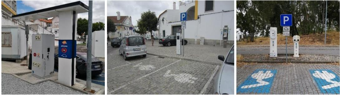
Figura 41. Tipologias de Postos de carregamento MOBI.E identificados no concelho de Évora: rápido (esquerda), semi-rápido (centro) e lento (direito)
